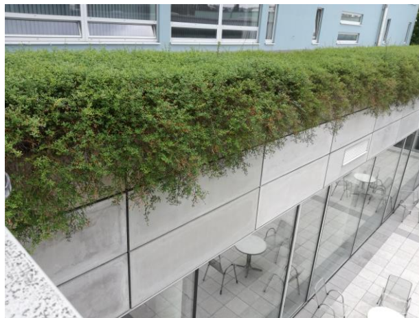
Fotografie fasádních panelů pod truhlíky a ukončení v návaznosti na dlažbu
