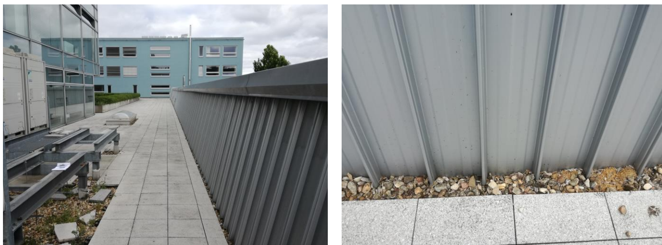
Fasádní systém z profilovaného plechu - hliníkové lamely.
