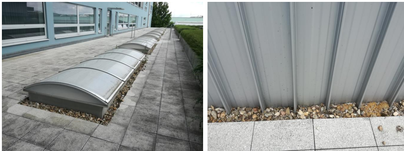
Fotografie stávajícího provedení kačírku okolo světlíků a u fasádního systému.
