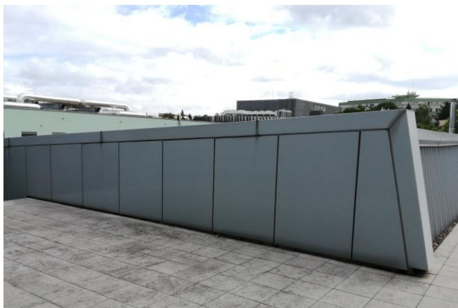
Fotografie bočního štítu, který je tvořen kazetovým fasádním systémem.
